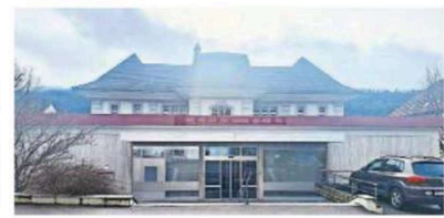
La police cantonale bernoise investira les anciens locaux de la Banque cantonale bernoise à Saint-Imier. PHOTO CLR
